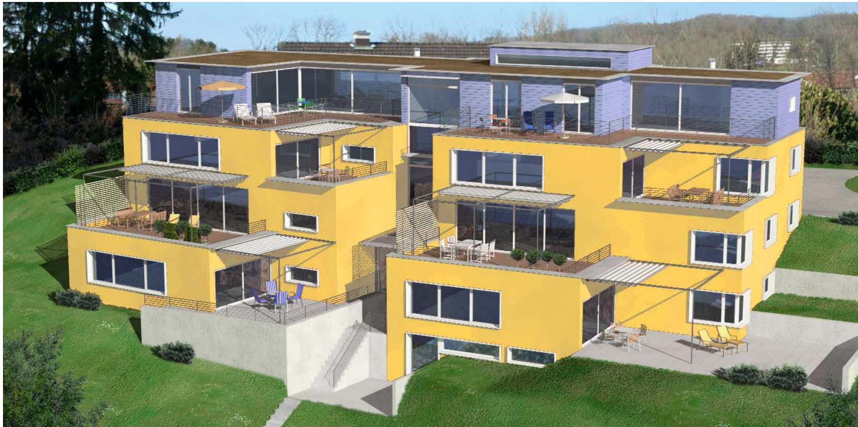
Keine Repräsentationsarchitektur: verschachtelte, jeweils um 90° gedrehte Terrassenstruktur
